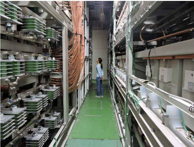
大型コンデンサーバンクシステム
