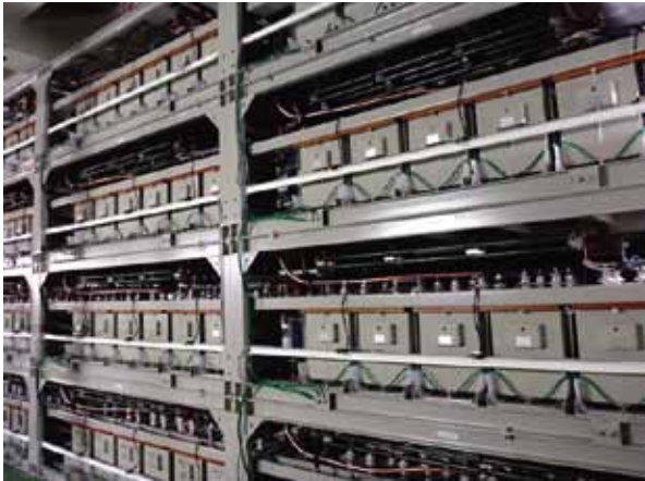
大型コンデンサーバンクシステム
